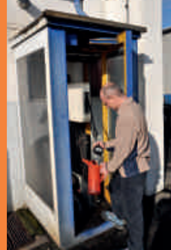
Ein ehemaliges Telefonhäuschen auf dem Betriebsgelände dient heute den Fahrern als Ölkabinett.
